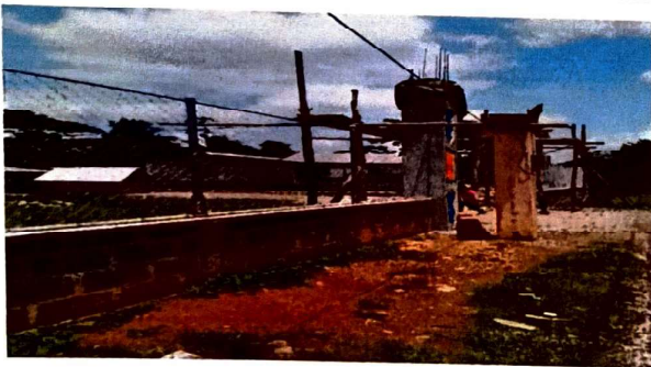
Foto 3: Muestra la colocacion de la malla perimetral
